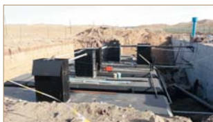
污水处理站建设
