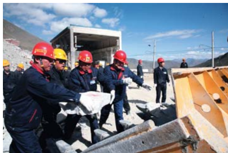
公司员工和施工队伍人员挑拣大块废石现场
