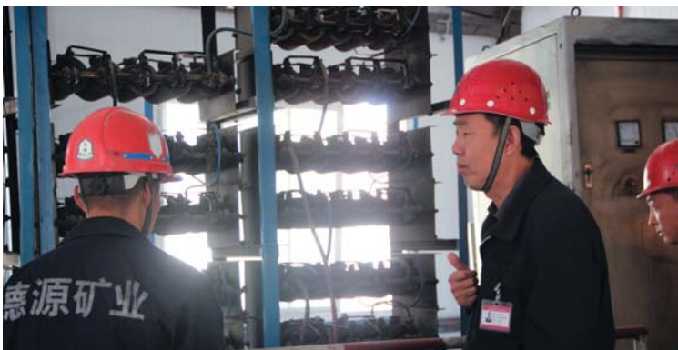
安全监察大队对陕西德源4620斜井卷扬室电机区进行检查
